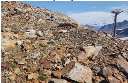
Foto 7: Silikat-Schuttflur mit beginnender Vegetationsbesiedelung im Bereich der geplanten Anschlusspisten (Bergstation).
