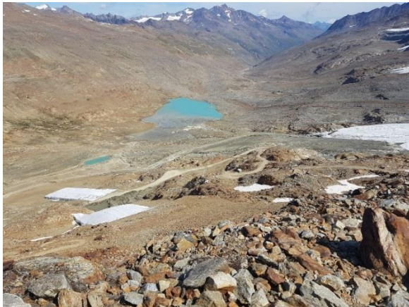
Foto 2: Blick auf das Projektgelände in Richtung Hochjoch.
