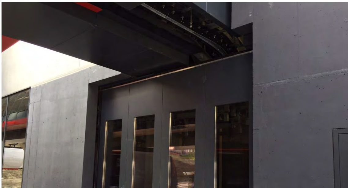
Sichtbare Betonoberflächen werde in deckender Farbe anthrazit gestrichen (Talstation PANORAMA Baujahr 2018)
