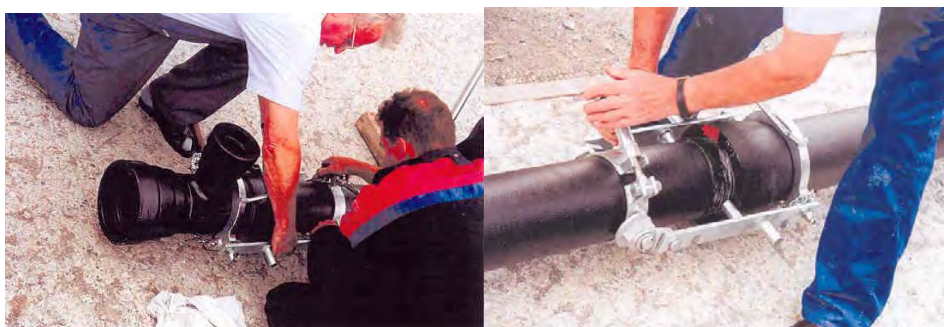
Beispiel Anschluß der Leitungen
