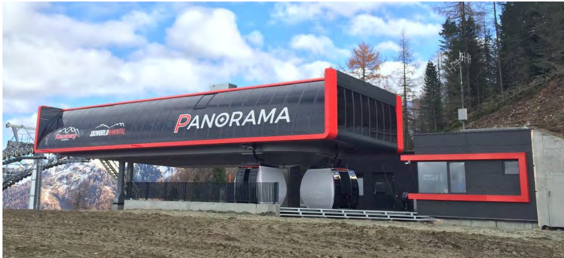
Bergstation der bestehenden Anlage PANORAMA (Baujahr 2018) als Vorlage für die Verkleidung der neuen Stationen der Anlage SONNENLIFT.
