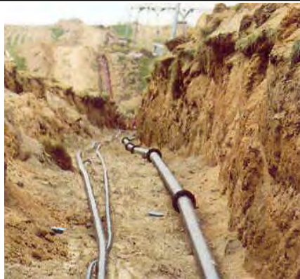
Verlegung der Leitungen
