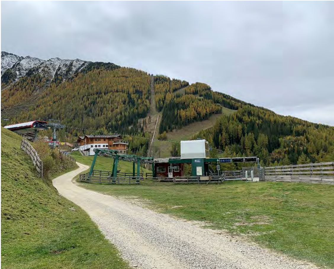
Bestehende und abzubrechende Talstation der Anlage SONNENLIFT.
