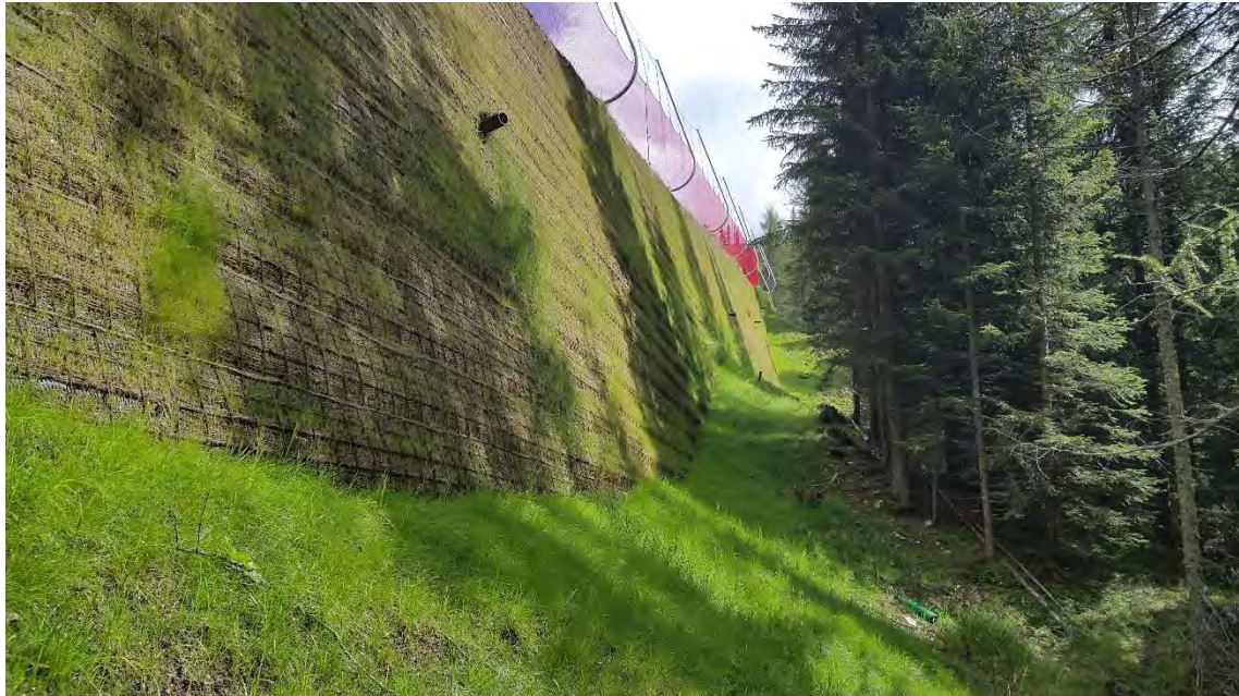
Ausführung von bewehrten Erdmauern
