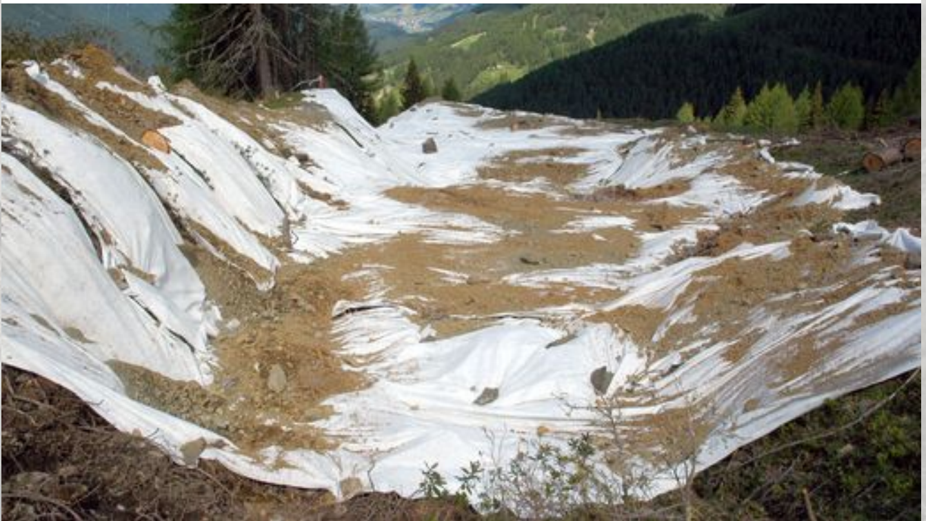
Abb. 11: Abdecken der Seilbahnmittelstation unterhalb des Stiergartens 2014
