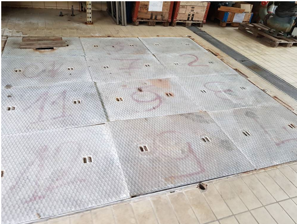
Foto 8: Dettaglio chiusini accesso vasca
