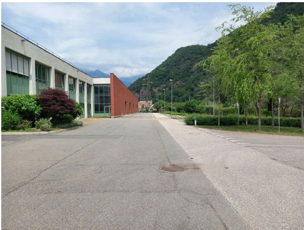
Foto 3: Da lato sud
