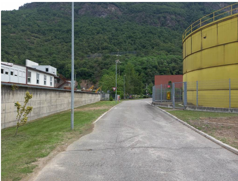
Foto 12: Viabilità lato nord
