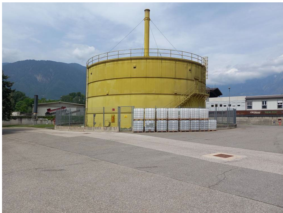
Foto 9: Da lato est – Gasometro esistente
