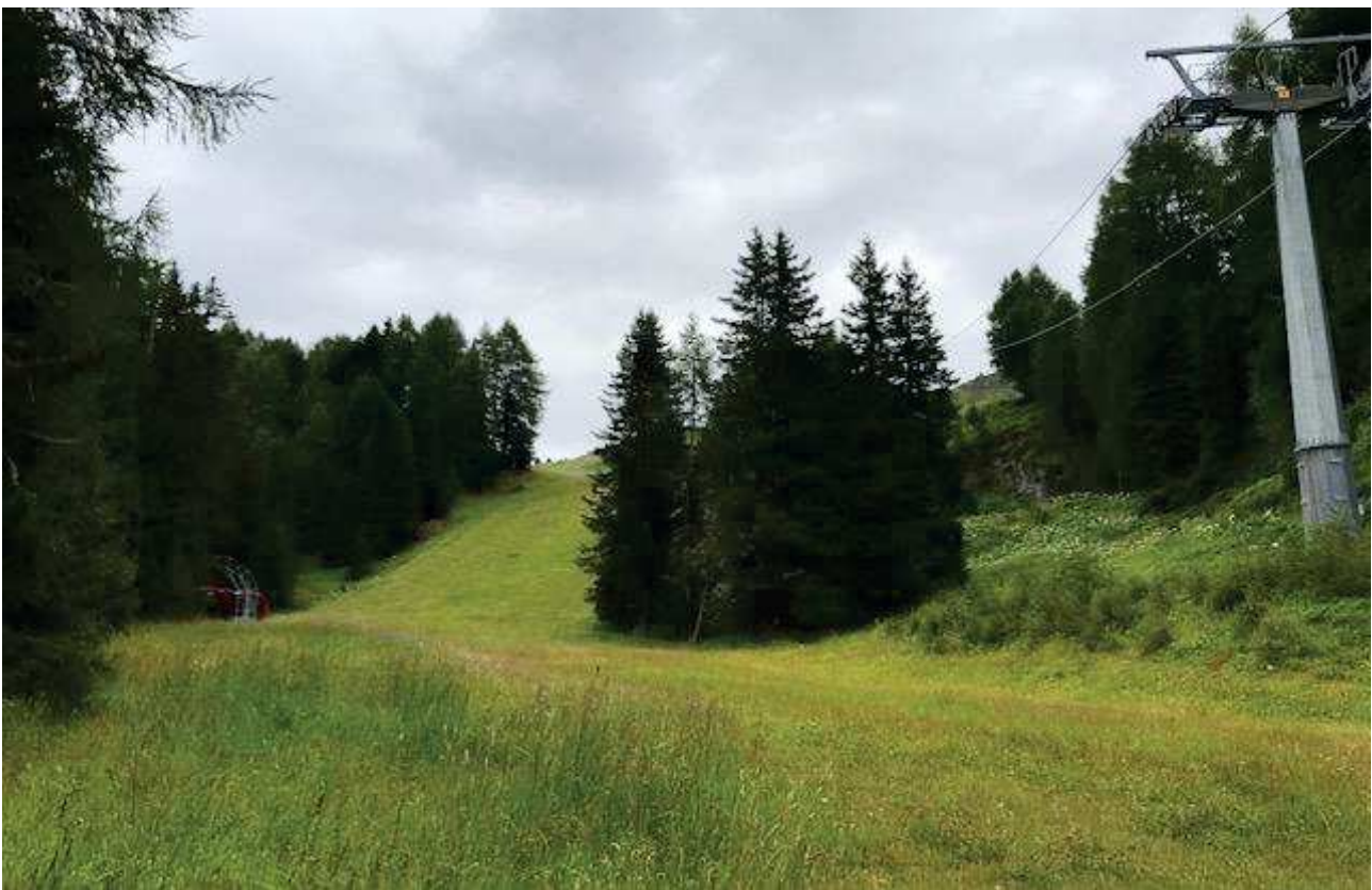
Fig. 11: zona di ampliamento della pista a carico del bosco a monte
