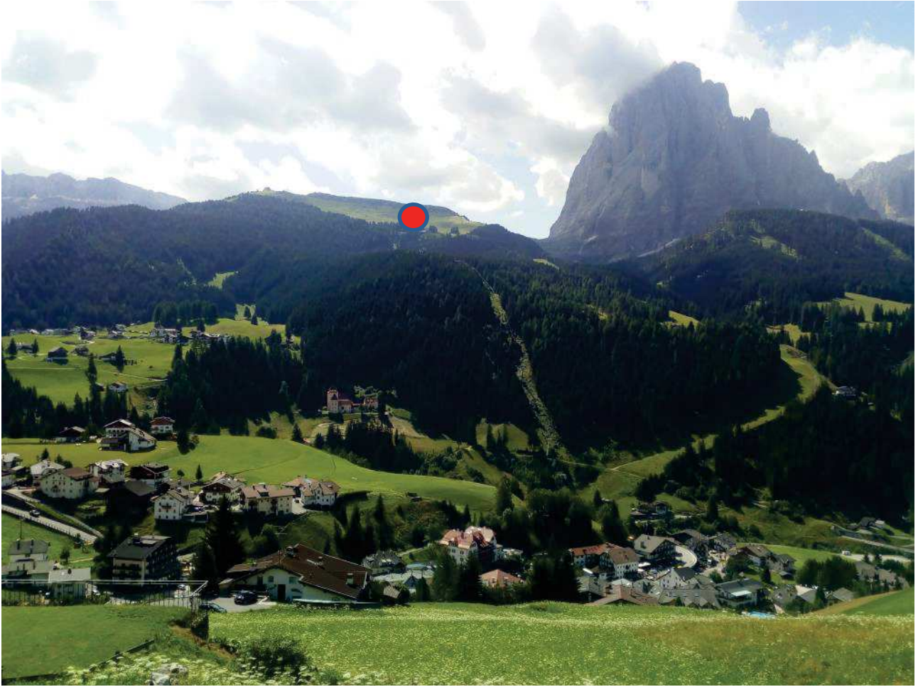
Fig. 7: vista del versante dove sale dal fondovalle la cabinovia con evidenziazione della zona d'intervento.
