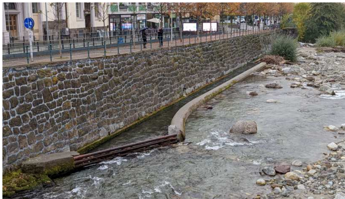
Abbildung 4: Links: Beispiel Entnahmekanal; Rechts: Beispiel Wärmetauscher
