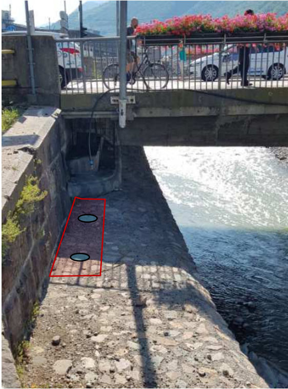
Sostegno ponte di tubi: a) destra orografica – Piccoli pali trivellati con trave di testa, b) sinistra orografica – Estensione della spalla esistente Ponte Loreto
