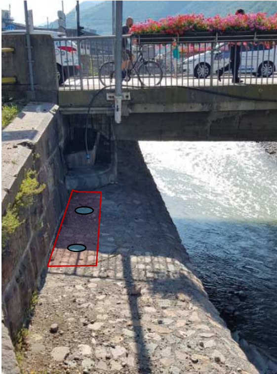
Auflager Rohrbücke: a) Orographisch rechts – Kleinbohrpfähle mit Kopfbalken, b) orographisch links – Verlängerung bestehendes Widerlager Loretostraße
