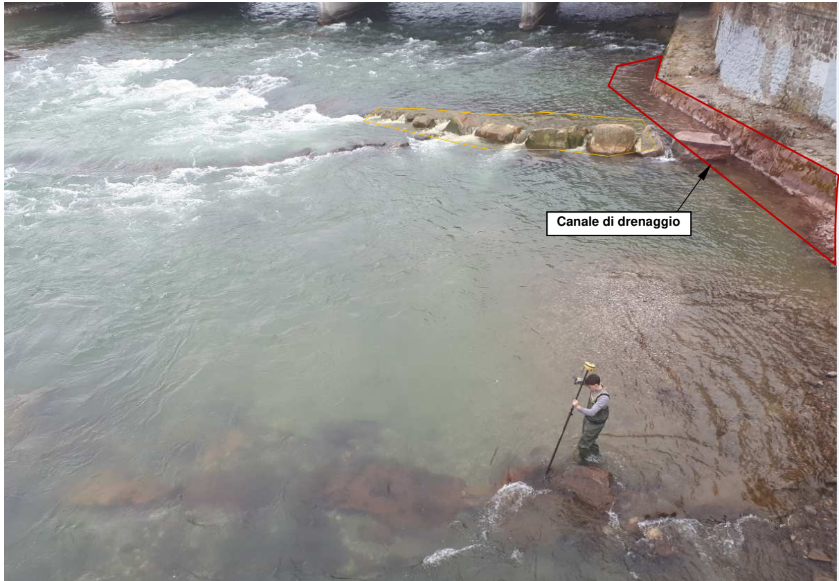
Demolizione del pennello esistente tra il ponte di Loreto e il ponte ferroviario per la realizzazione di un canale di deviazione
