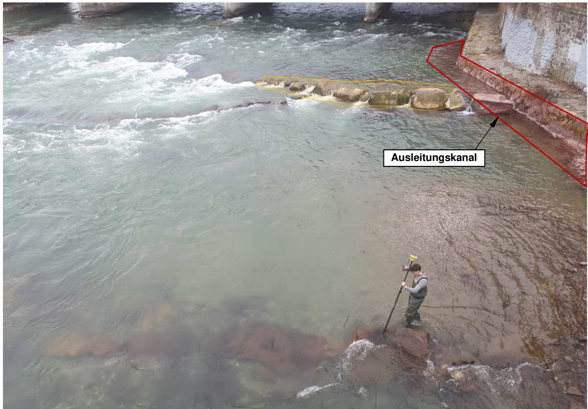
Abbruch bestehender Buhne zwischen Loretobruck und Eisenbahnbrücke für Ausleitungskanal
