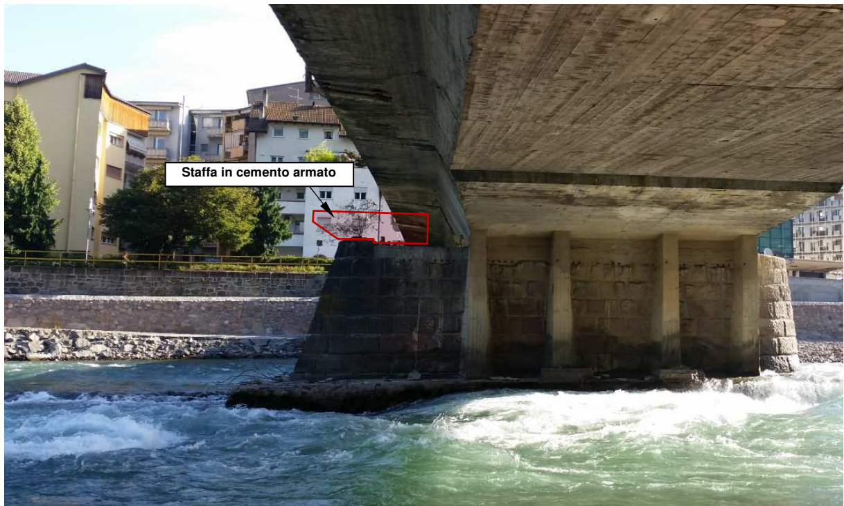
Ponte con tubo di sostegno - Ponte di Loreto a pilastro centrale esistente
