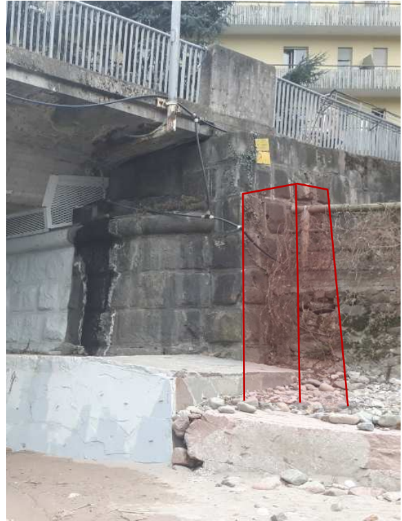
Auflager Rohrbücke: a) Orographisch rechts – Kleinbohrpfähle mit Kopfbalken, b) orographisch links – Verlängerung bestehendes Widerlager Loretostraße
