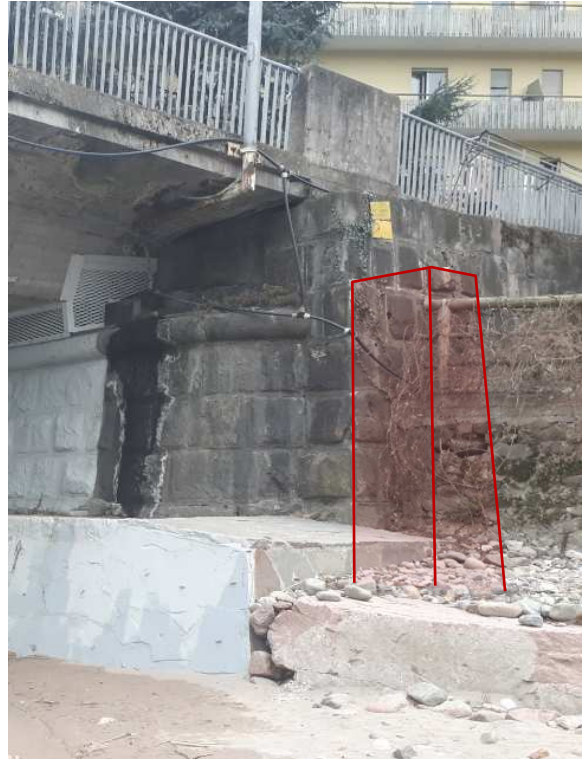
Sostegno ponte di tubi: a) destra orografica – Piccoli pali trivellati con trave di testa, b) sinistra orografica – Estensione della spalla esistente Ponte Loreto
