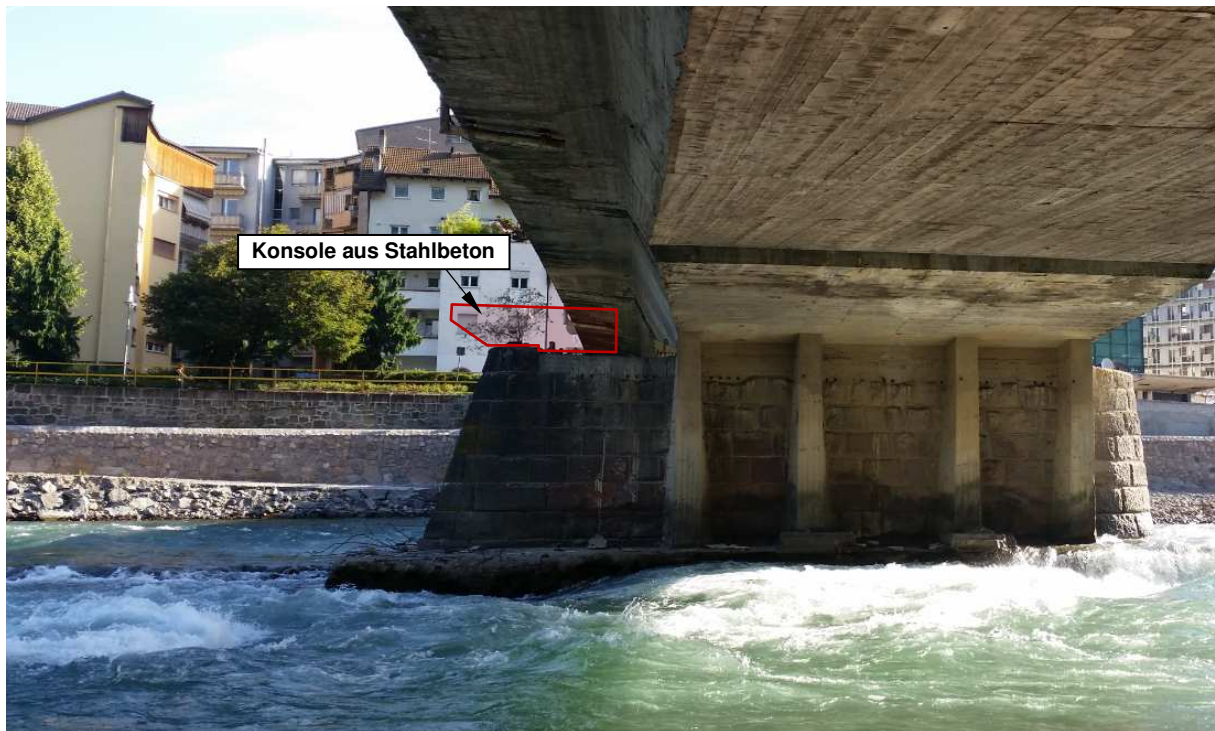
Auflager Rohrbücke – Bestehender Mittelpfeiler Loretostraße
