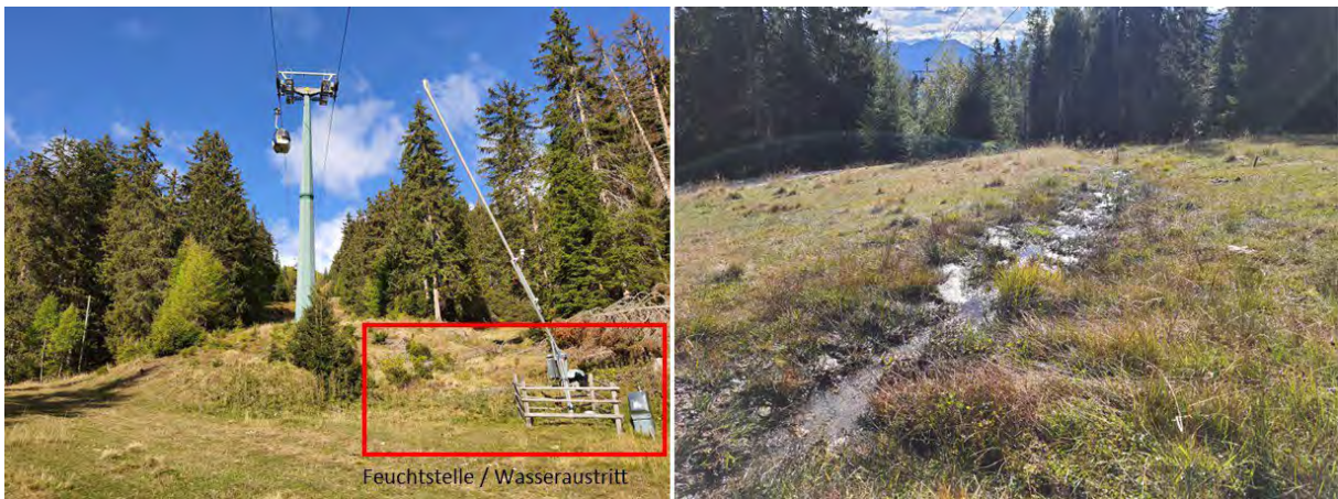
Abbildung 9: Wasseraustritt im Bereich der Querung Skipiste Gringesboden
