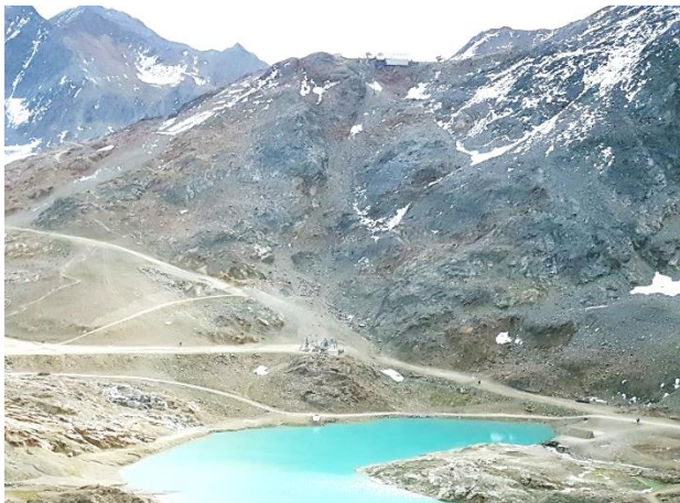
Foto 1: Hinter dem Speichersee sind die alten Anlagen, die abgebrochen werden sollen, erkennbar.
