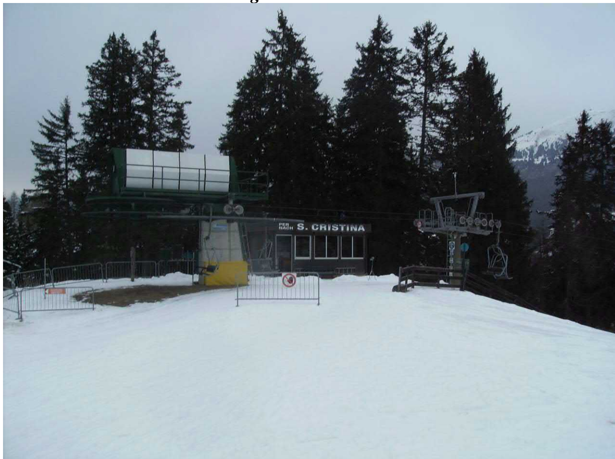
Foto 4: Position bestehende Bergstation
