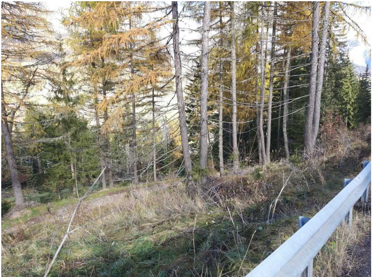
Foto 10: Linie Bereich Stütze S6
