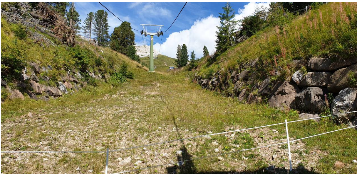
Abbildung 12: Im Geländeeinschnitt verlaufender, unterster Teil der Lifttrasse
