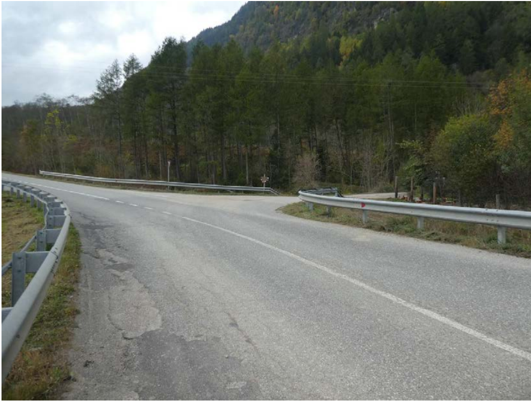
Abbildung 12: Zufahrt in Fahrtrichtung Mühlwald
