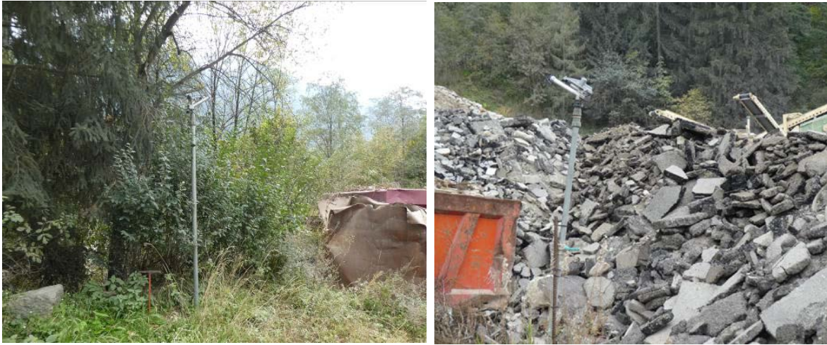
Abbildung 16: Bestehende Beregnungsanlage gegen Staubentwicklung
