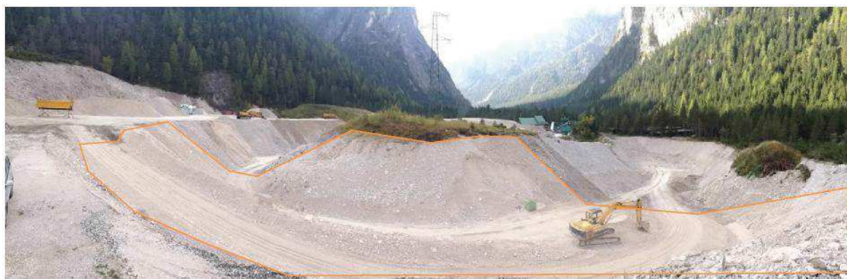
L'area della rampa visibile sarà riempita all'incirca fino al punto in cui si trova l'escavatore.
