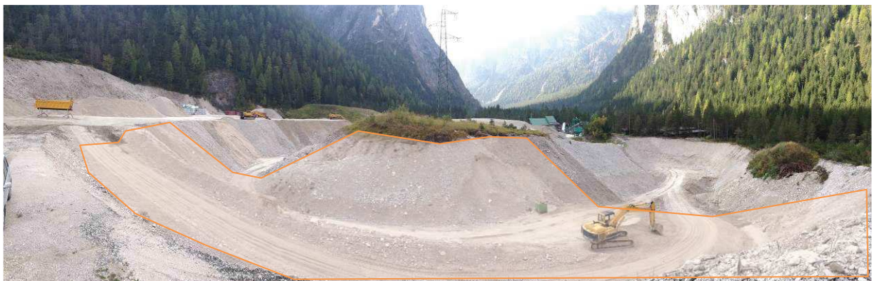
Der Bereich der sichtbaren Rampe bis ca. zum Standort des Baggers soll verfüllt werden.
