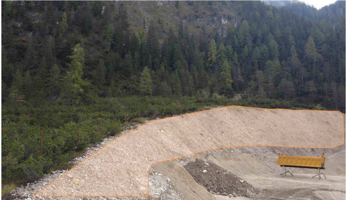
Der angeschnittene Schwemmfächer des Meieralpelbaches und die Böschung der abgebauten Grube mit der bereits begonnenen Vegetationsentwicklung.
