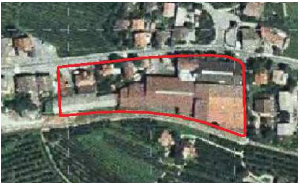
Stralcio da un'ortofoto del 1999 - La via Weingartner e la linea ferroviaria Merano-Malles a Sud; si può apprezzare la consistenza del volume dei magazzini "OGA" esistenti sull'area oggetto di studio, demoliti nel 2006
