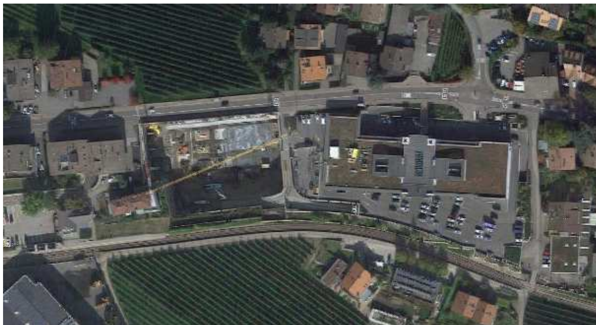
Stralcio da un'ortofoto del 2018 - Si vedono la via Weingartner, la linea ferroviaria e , l'edificio ultimato nel 2012 oltre all'area sulla quale si sviluppa l'ampliamento oggetto di screening
