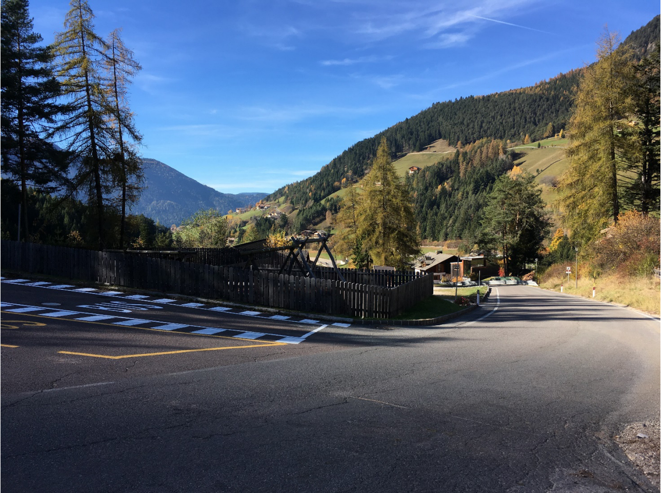
Abbildung 14 - Talstation Tierser Seilbahn
