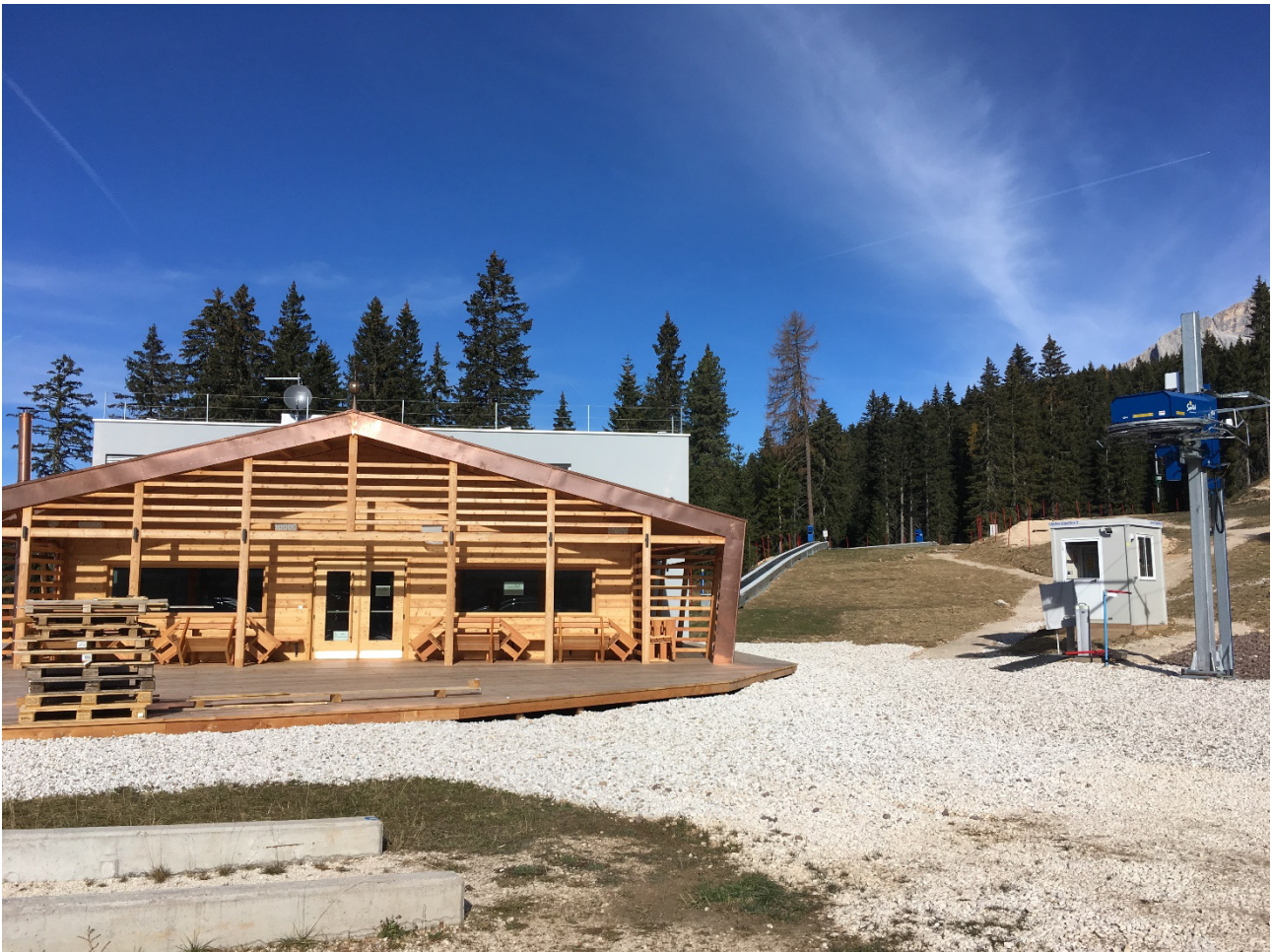
Abbildung 15 - Bergstation Tierser Seilbahn (am Ende des Förderbandes bei der Lärche)
