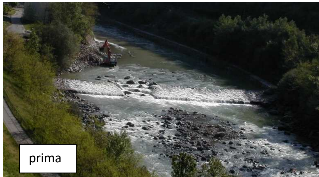
Intervento all'altezza del depuratore di Barbiano
