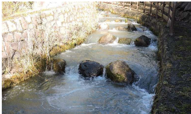
Passaggio pesci all'opera di presa "Fermata di Funes" Dell'impianto di Ponte Gardena
