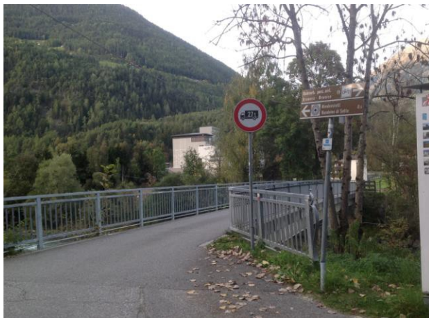
Illustrazione 5: Attraversamento sul fiume Rienza
