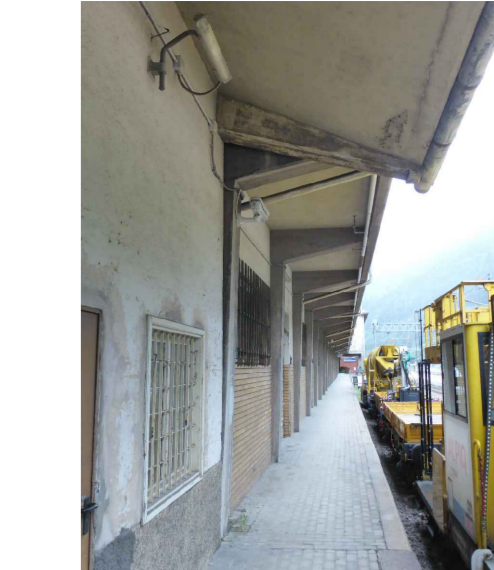
Vista lato binari Stazione
