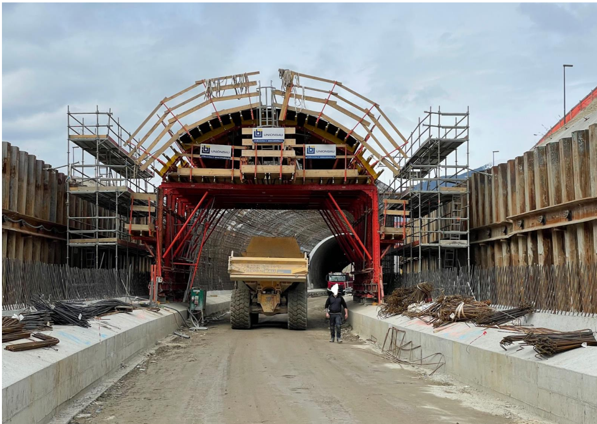
Figura 3 – Condizioni attuali circolazione pista di cantiere
