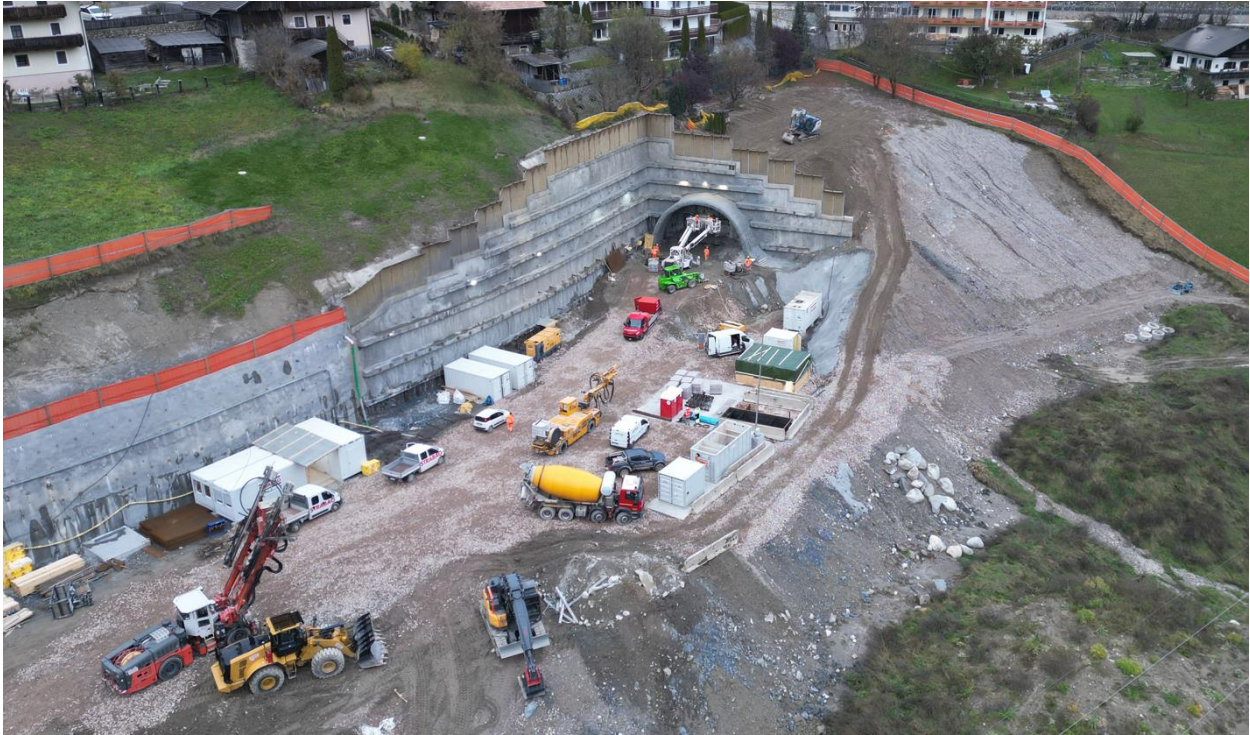
Figura 1 – Vista cantiere operativo C02-C03
